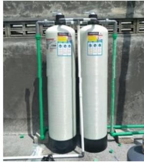
**Gambar 1.** Hasil Instalasi Filter Tabung
